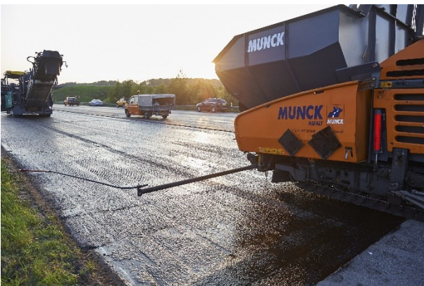
Billede fra asfaltudlægningen
