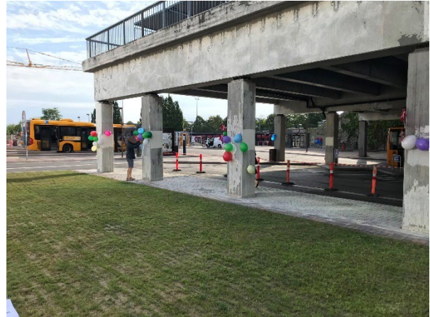
Billede af busholdepladsen ved Hundige station inden indvielsen
