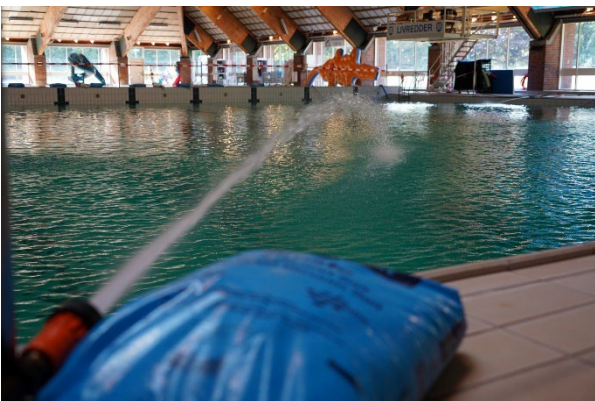
Billede fra udskiftningen af fliser - opfyldning af det store bassin i Greve Svømmehal
