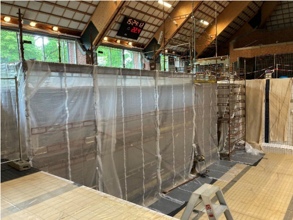
Billede fra udskiftningen af fliser i Greve Svømmehal
